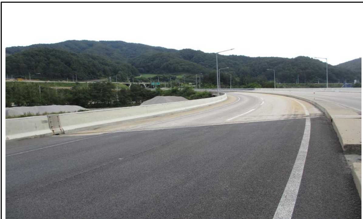
교량 상부 전경
